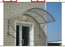
Козырек металлический из профильной трубы, с покрытием монолитный поликарбонат 4мм и полимерной окраской.
